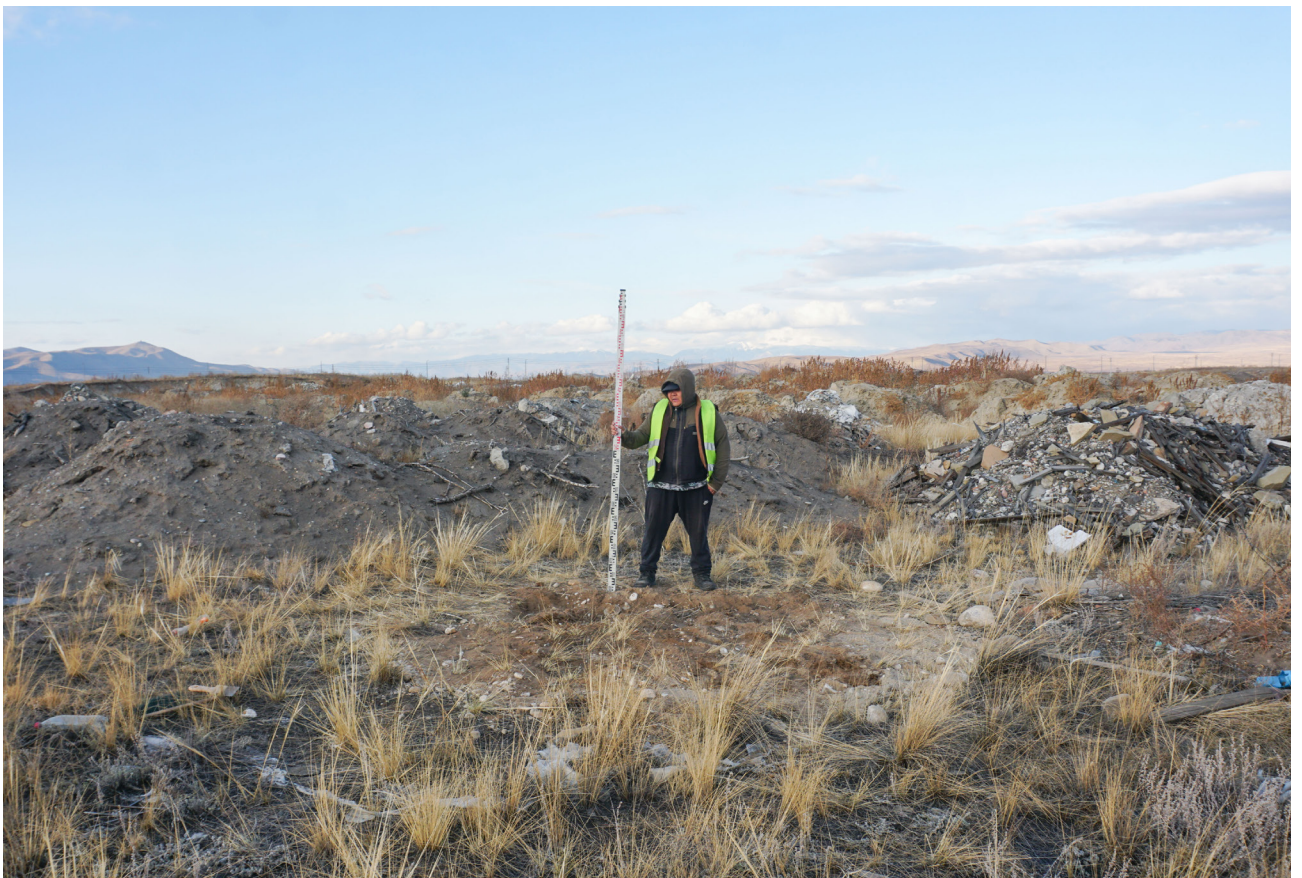
Рис. 33. Центр реабилитации. Шурф №2. Общий вид с юга после рекультивации.
