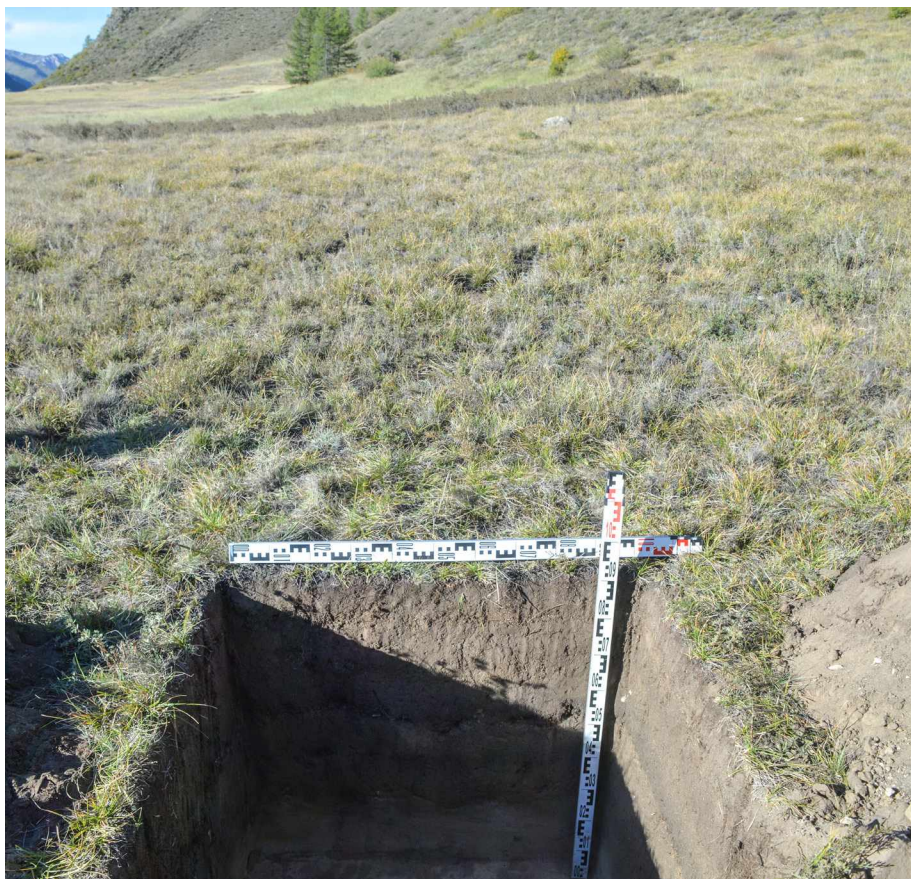
Рис. 56. Автодорога. Шурф №2. Северная стенка. Вид с юга.
