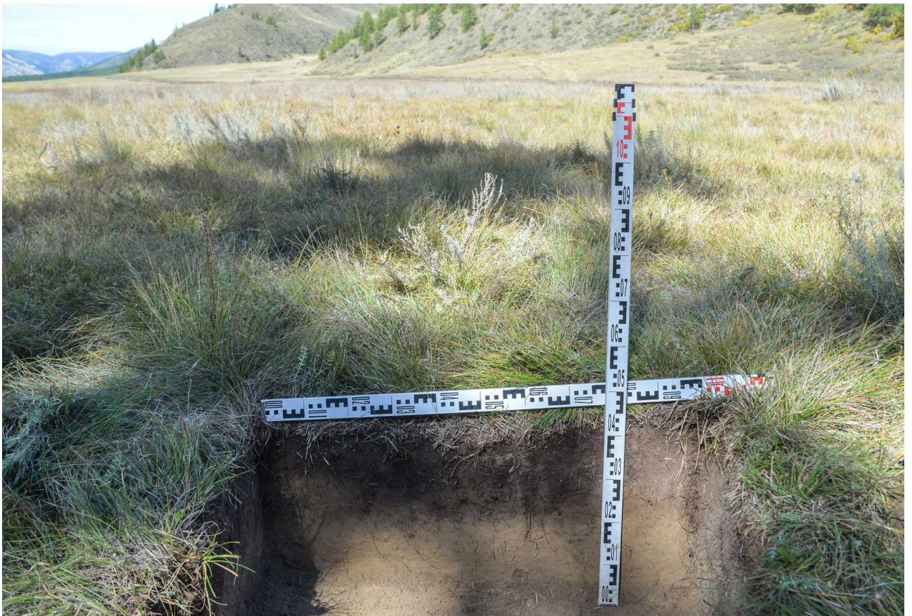
Рис. 60. Автодорога. Шурф №3. Северная стенка. Вид с юга.
