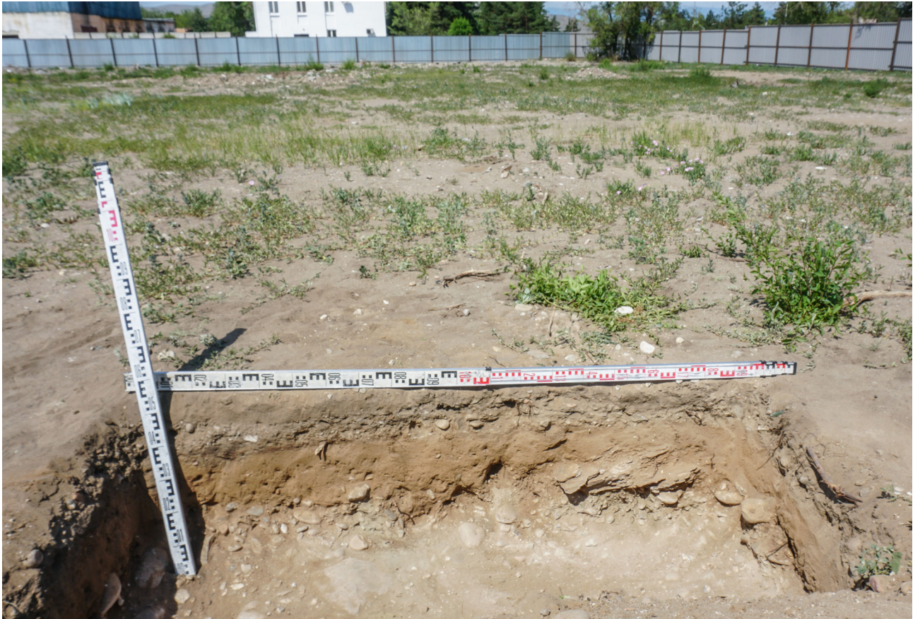
Рис. 25. Административное здание Управления ФНС. Шурф №1. Северная стенка. Вид с юга.
