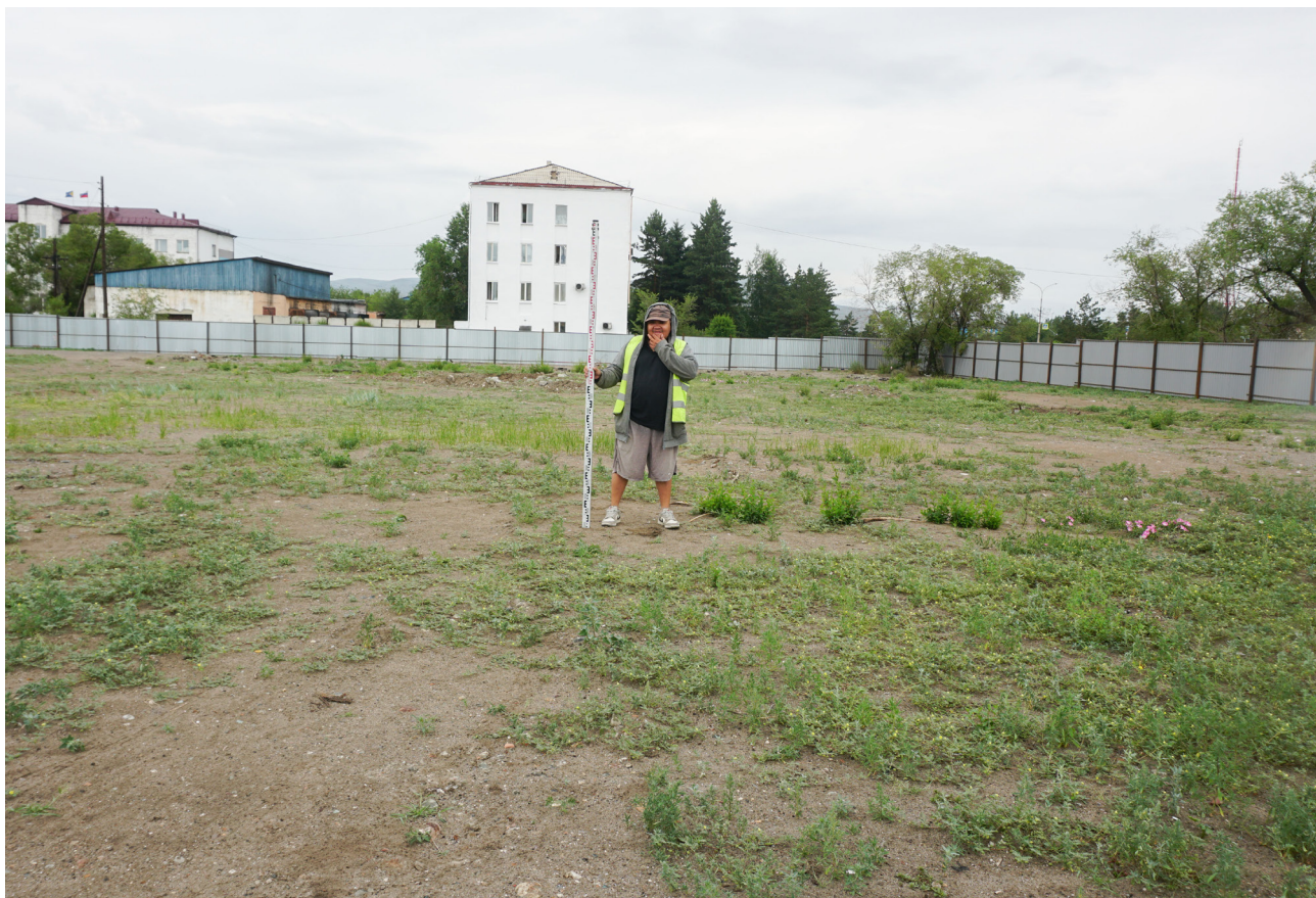
Рис. 23. Административное здание Управления ФНС. Шурф №1. Общий вид с юга до раскопок.
