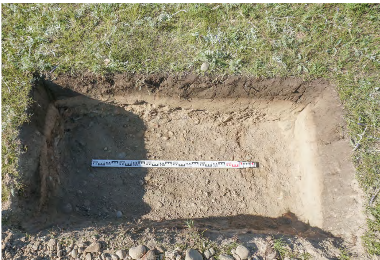
Рис. 40. ПС 220 кВ Тоора-Хем. Шурф №3. Общий вид с юга.
