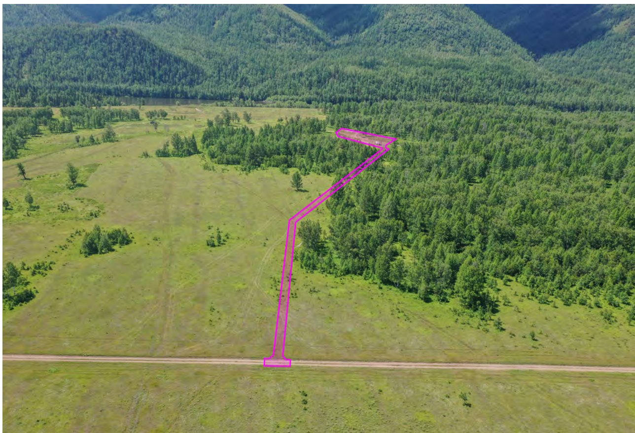
Рис. 13. ПС 220 кВ Тоора-Хем. Аэрофотосъемка с нанесенным контуром территории проектирования. Общий вид с СВ.
