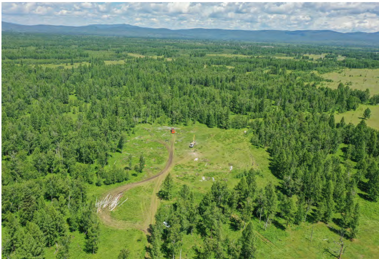
Рис. 14. ПС 220 кВ Тоора-Хем. Аэрофотосъемка. Вид с ЮЗ.
