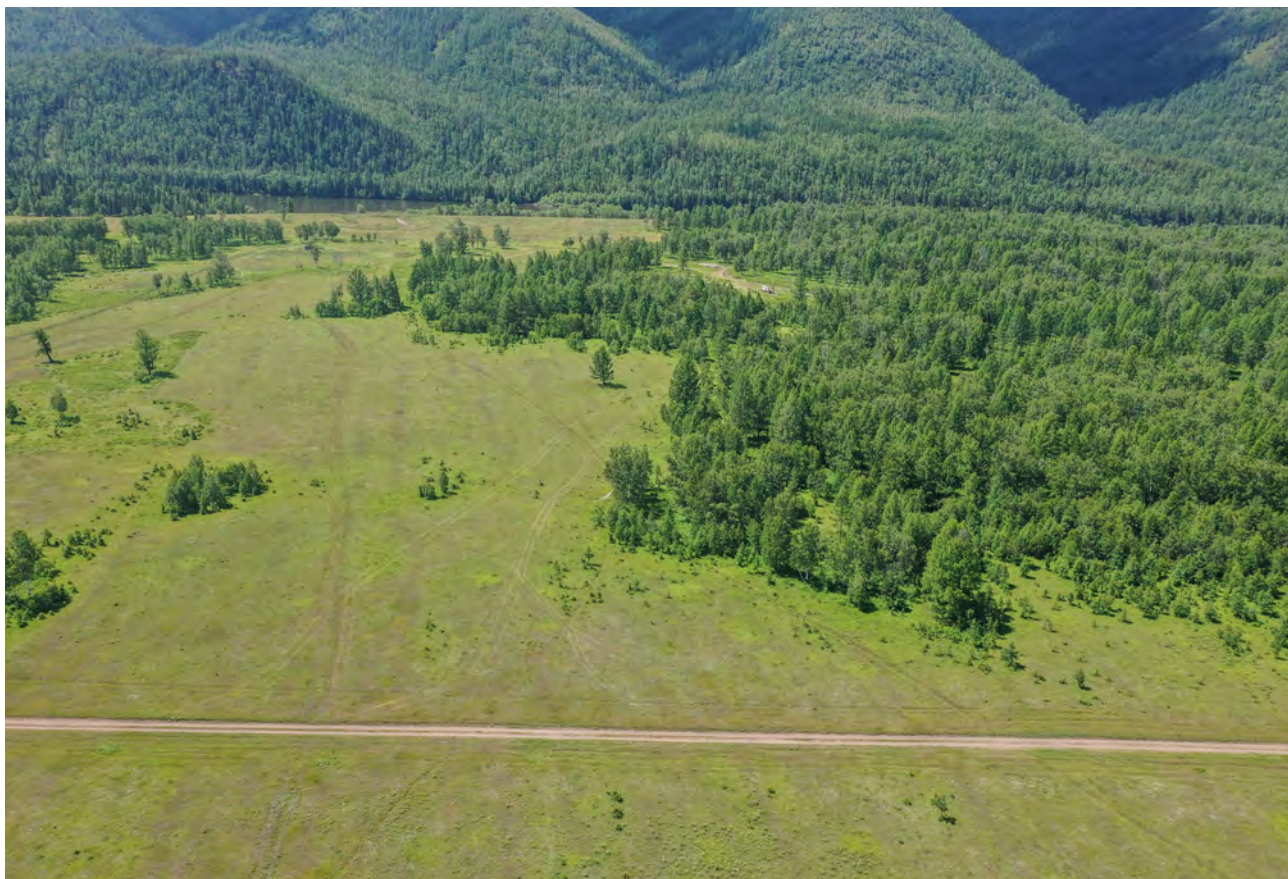
Рис. 12. ПС 220 кВ Тоора-Хем. Аэрофотосъемка. Общий вид с СВ.
