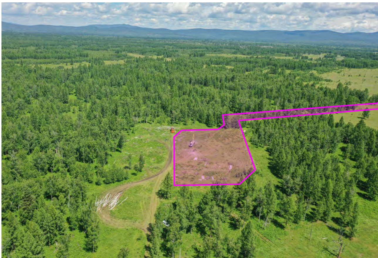
Рис. 15. ПС 220 кВ Тоора-Хем. Аэрофотосъемка с нанесенным контуром территории проектирования. Вид с ЮЗ.
