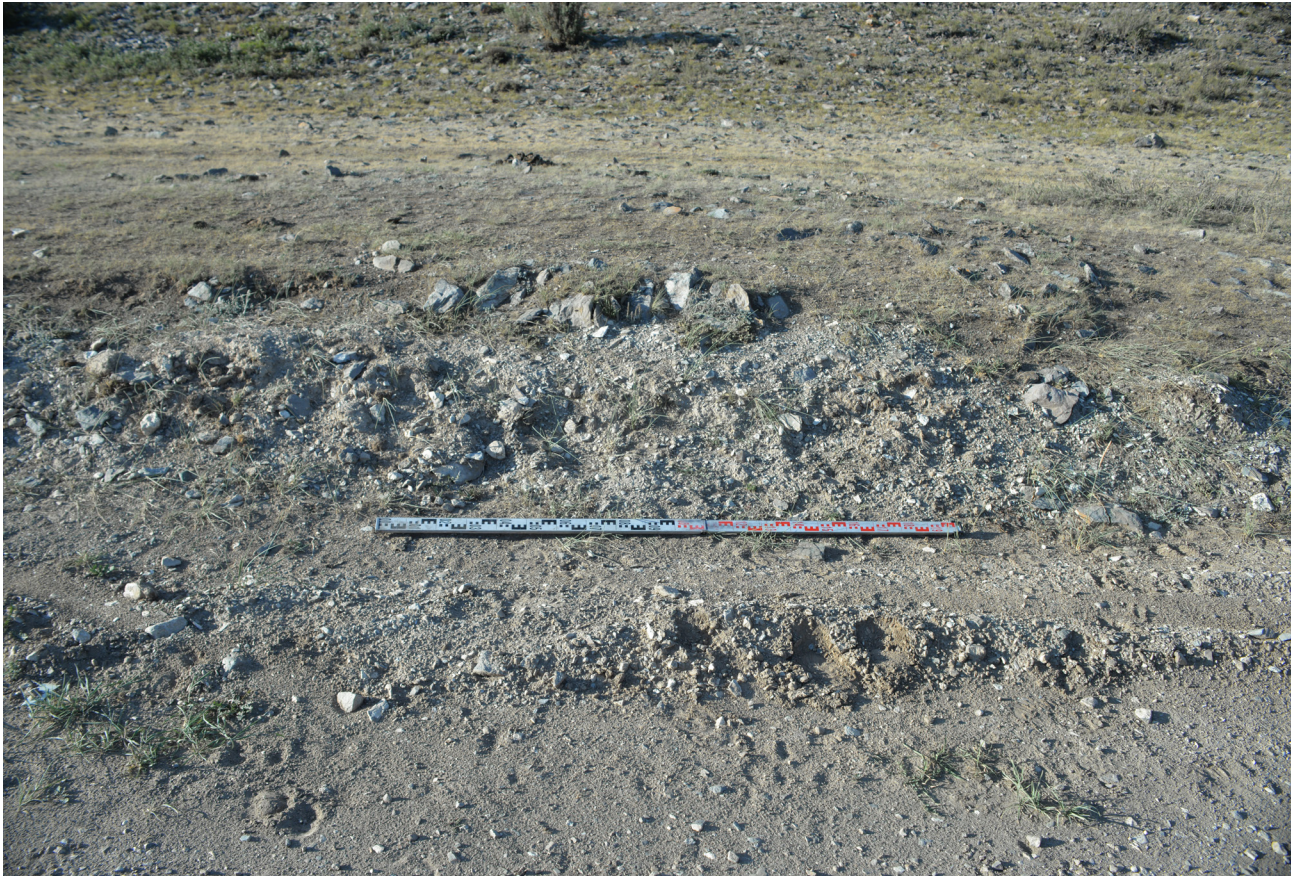
Рис. 55. Автомобильная дорога. ВОАН “Курганный могильник Качык-1”. Курган №1. Деталь, поврежденная автомобильной дорогой насыпь кургана. Вид с ЮЮЗ.
