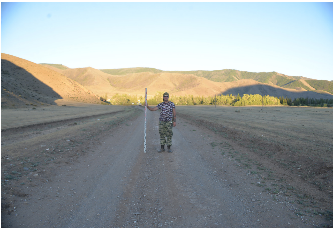
Рис. 25. Автомобильная дорога. Вид на территорию проектирования от точки видовой фотофиксации №7 с СЗ.
