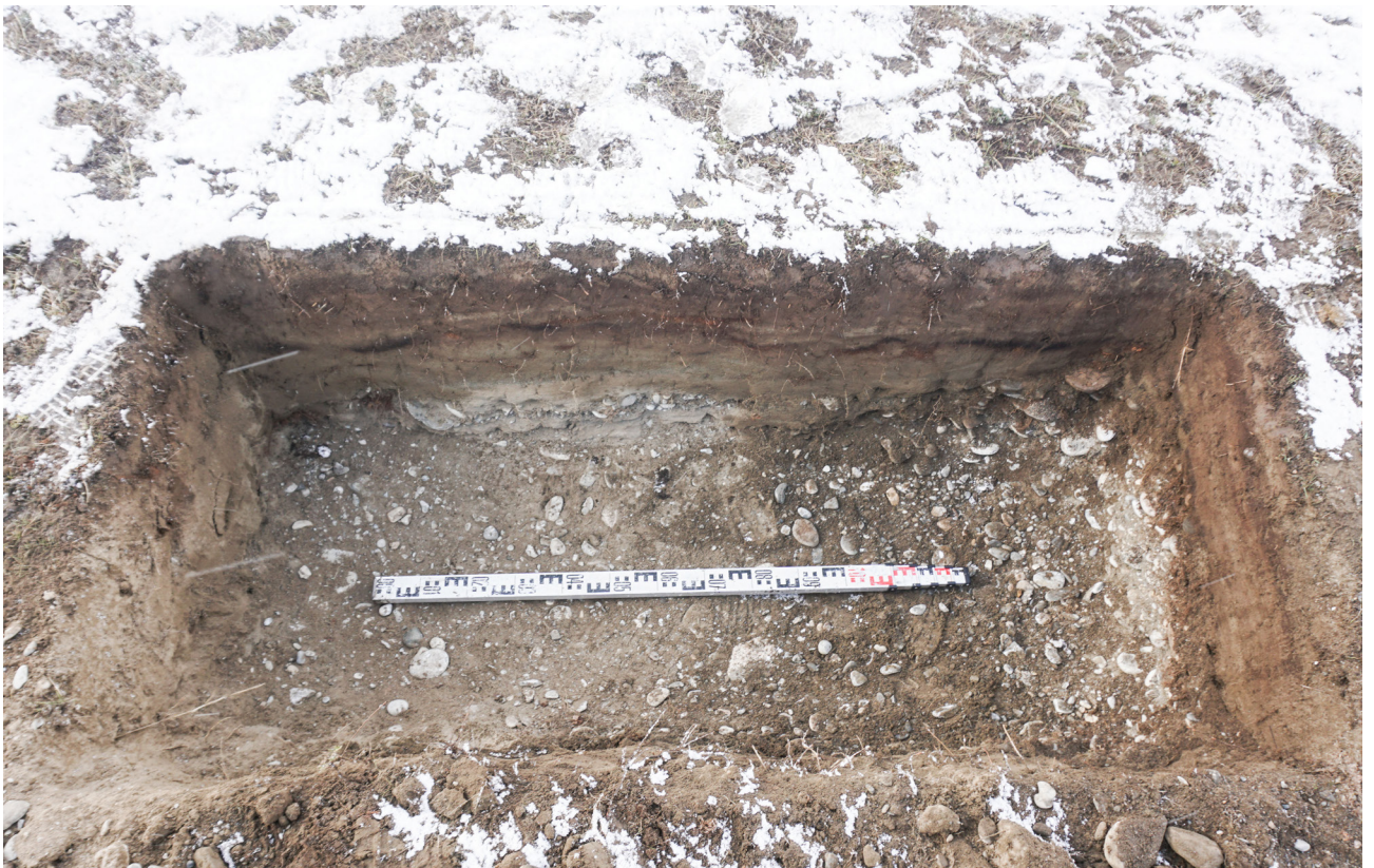
Рис. 112. Автомобильная дорога. Шурф №4. Общий вид с юга.
