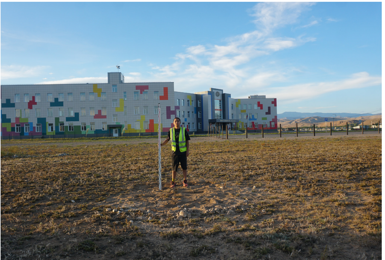
Рис. 50. Детский сад. Шурф №1. Общий вид с юга после рекультивации.
