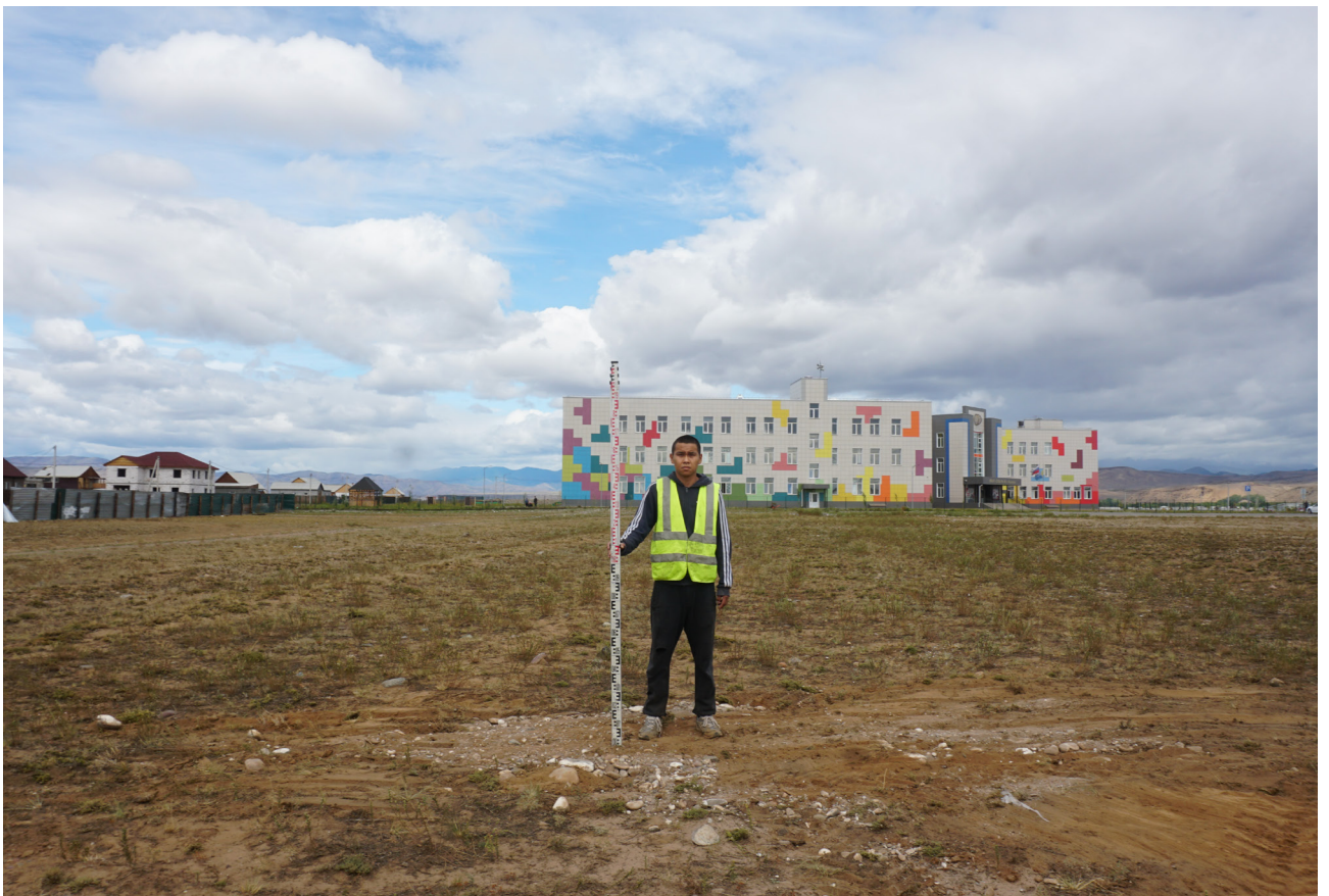
Рис. 58. Детский сад. Шурф №3. Общий вид с юга после рекультивации.
