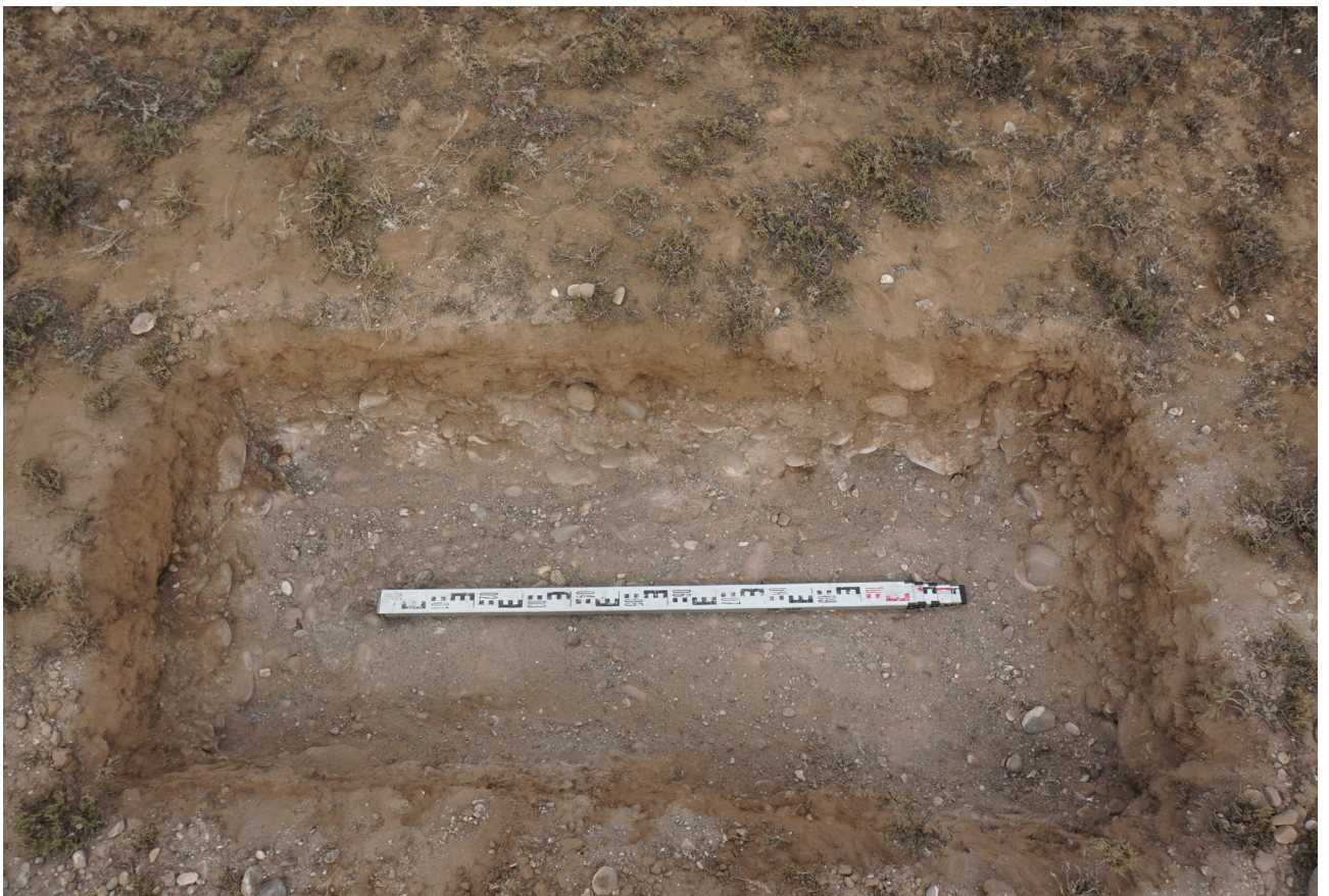
Рис. 52. Детский сад. Шурф №2. Общий вид с юга.
