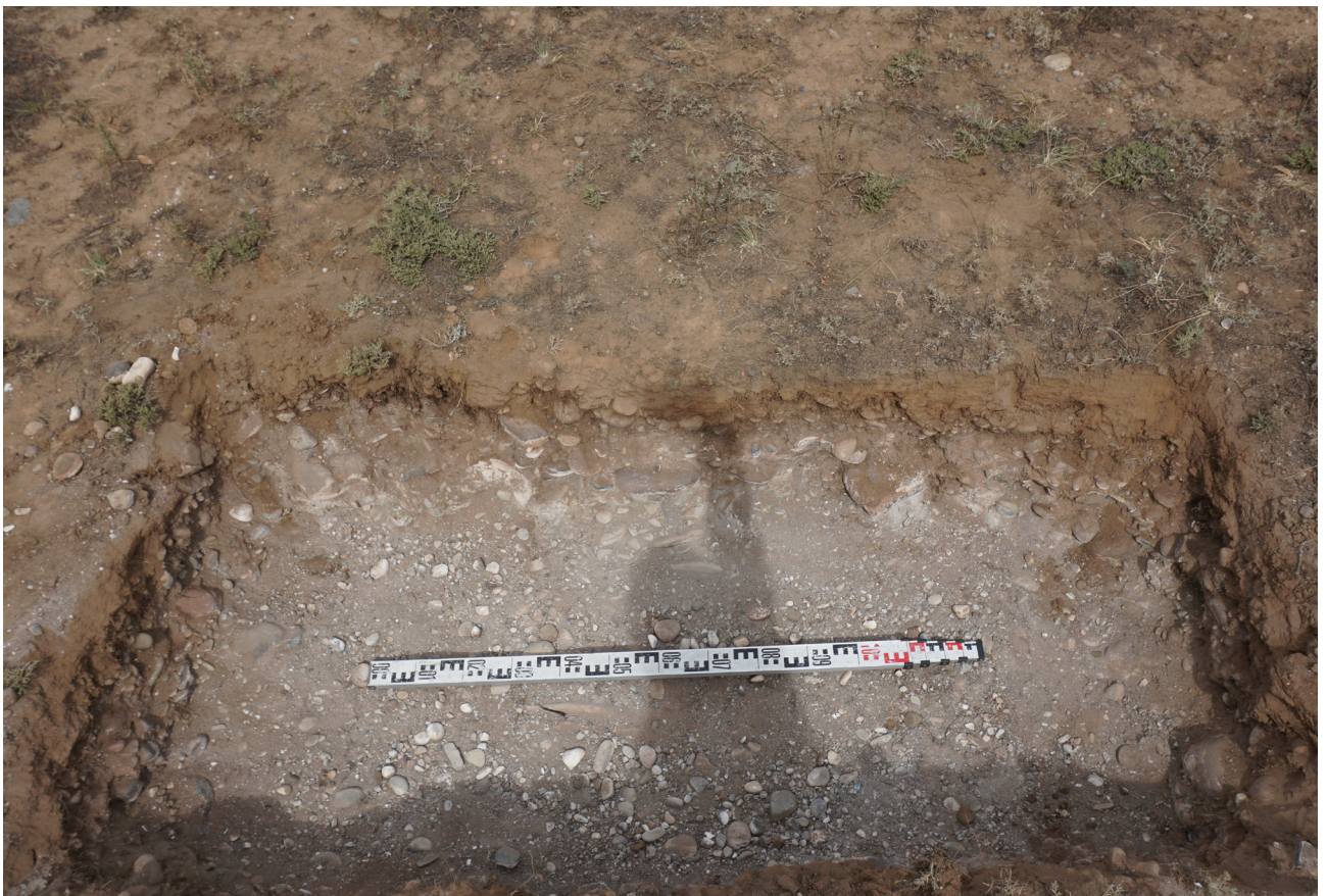
Рис. 56. Детский сад. Шурф №3. Общий вид с юга.
