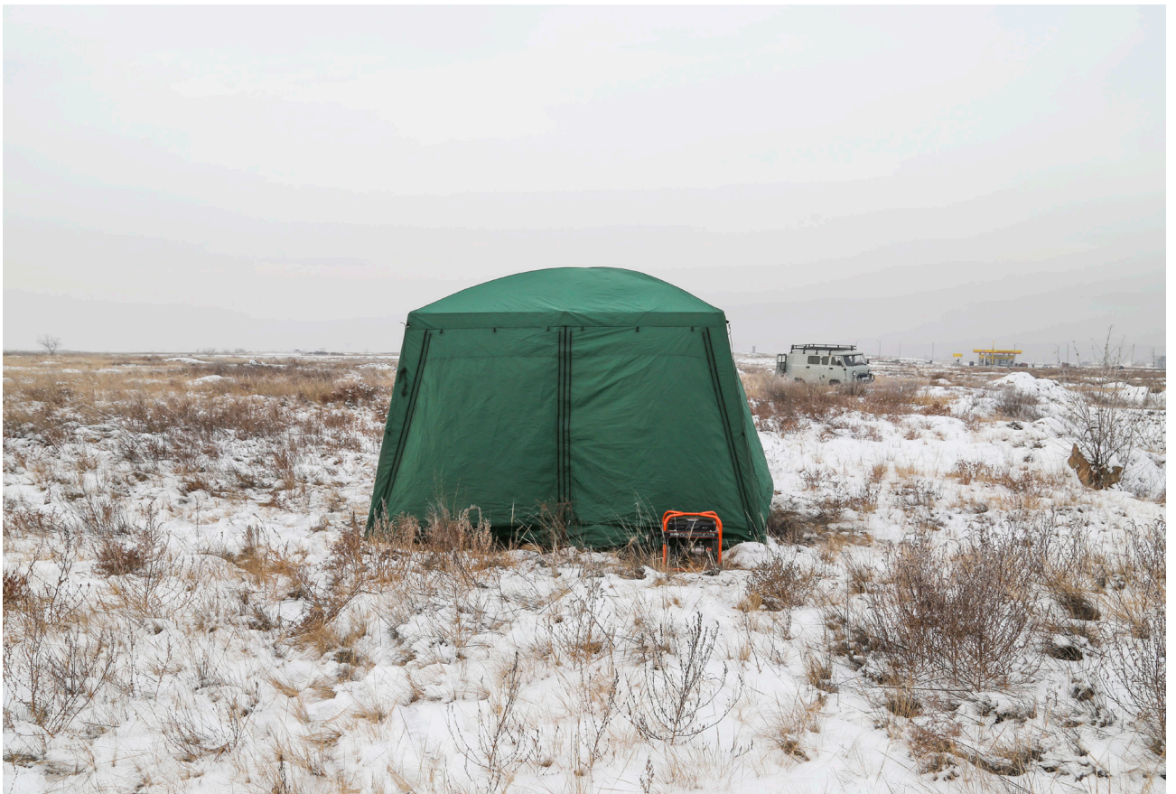
Рис. 15. Автовокзал в г. Кызыл. Рабочие моменты. Проведение шурфовочных работ в павильоне в условиях низких температур. Шурф №1.
