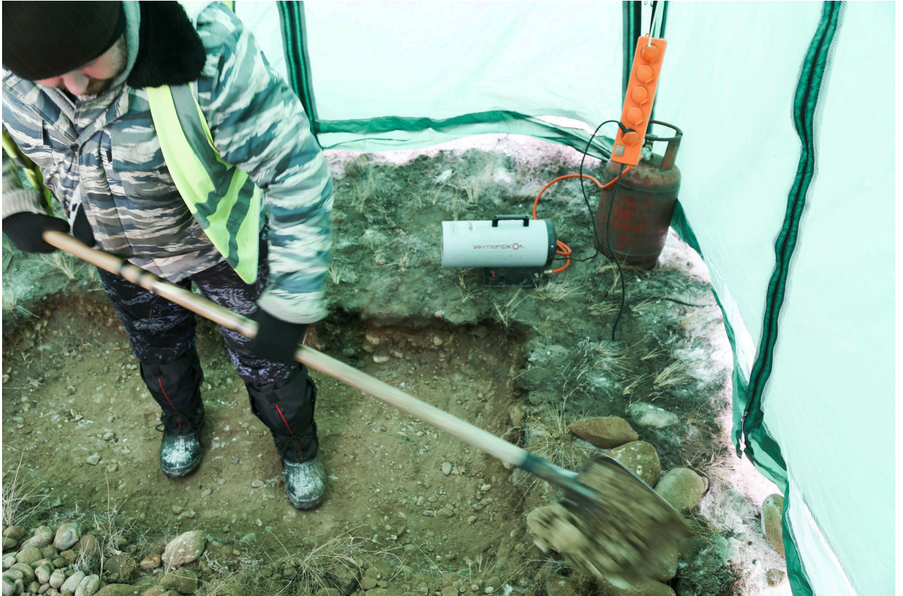
Рис. 17. Автовокзал в г. Кызыл. Рабочие моменты. Проведение шурфовочных работ в отапливаемом павильоне. Шурф №1.
