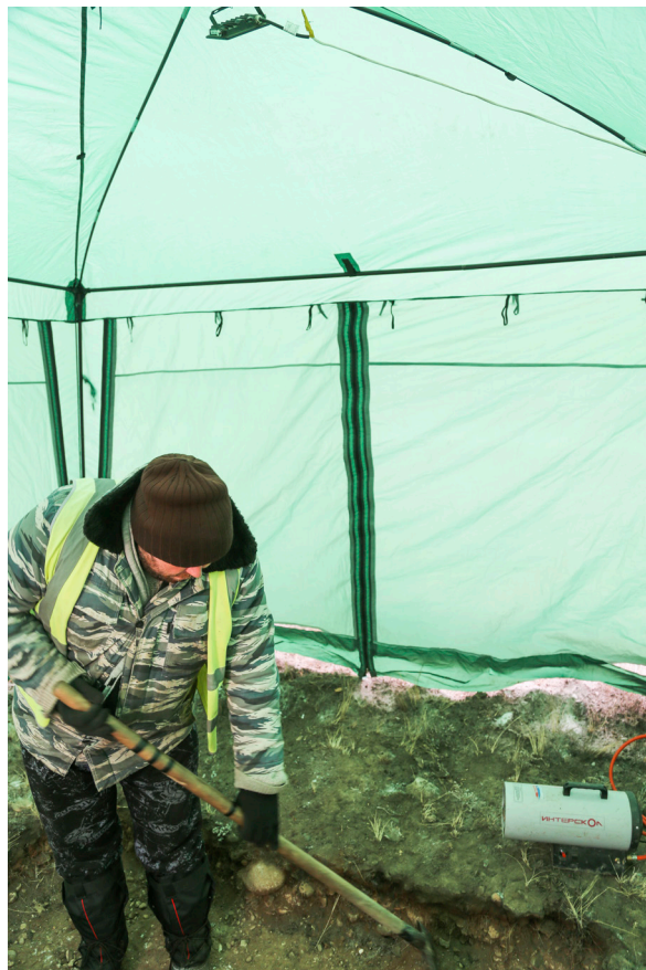
Рис. 18. Автовокзал в г. Кызыл. Рабочие моменты. Проведение шурфовочных работ в отапливаемом павильоне. Шурф №1.
