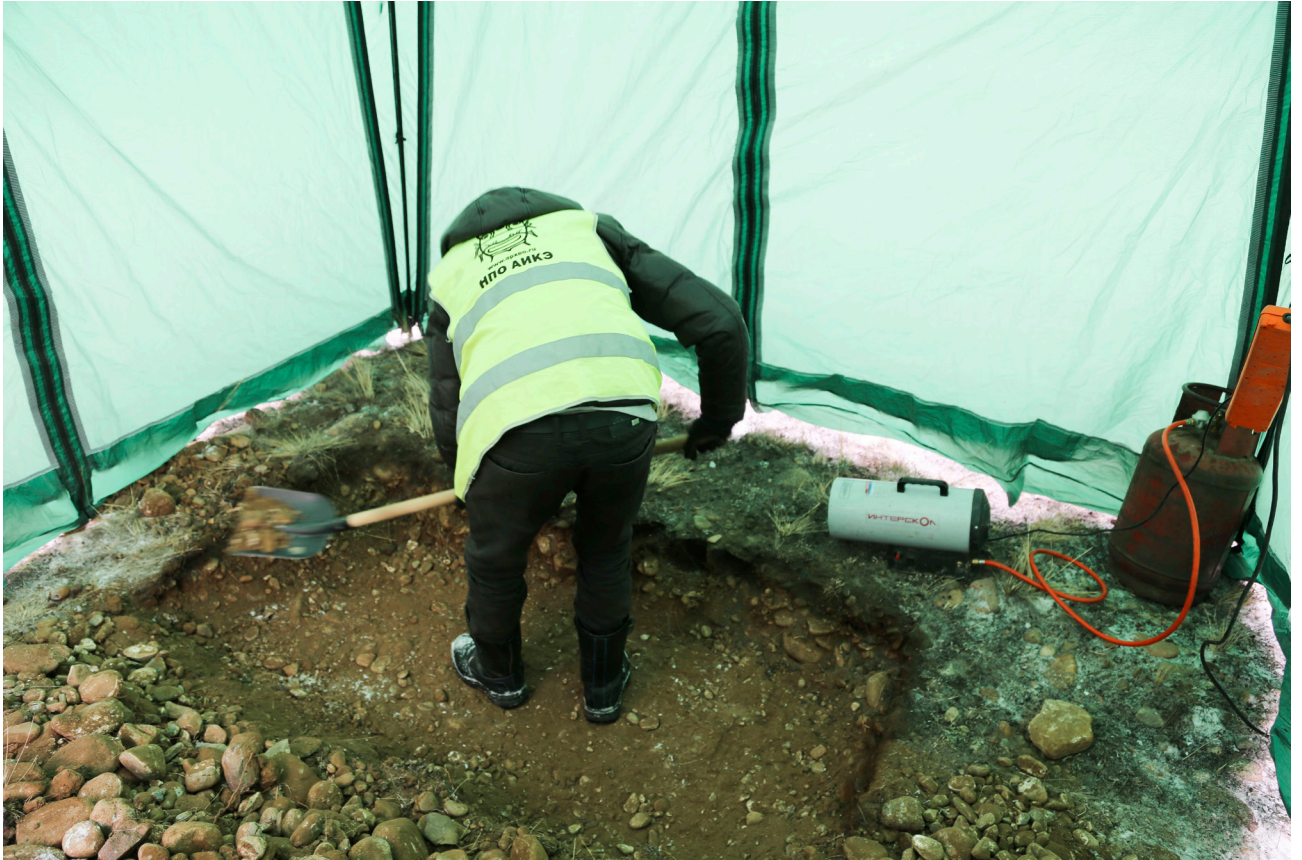
Рис. 19. Автовокзал в г. Кызыл. Рабочие моменты. Проведение шурфовочных работ в отапливаемом павильоне. Шурф №2.
