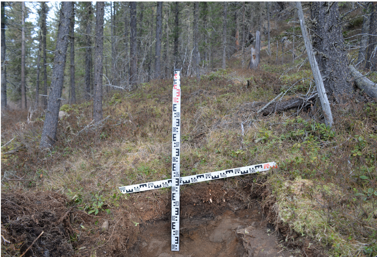
Рис. 32. Увеличение высоты дамбы. Северный участок. Шурф №1. СЗ стенка. Вид с ЮВ.
