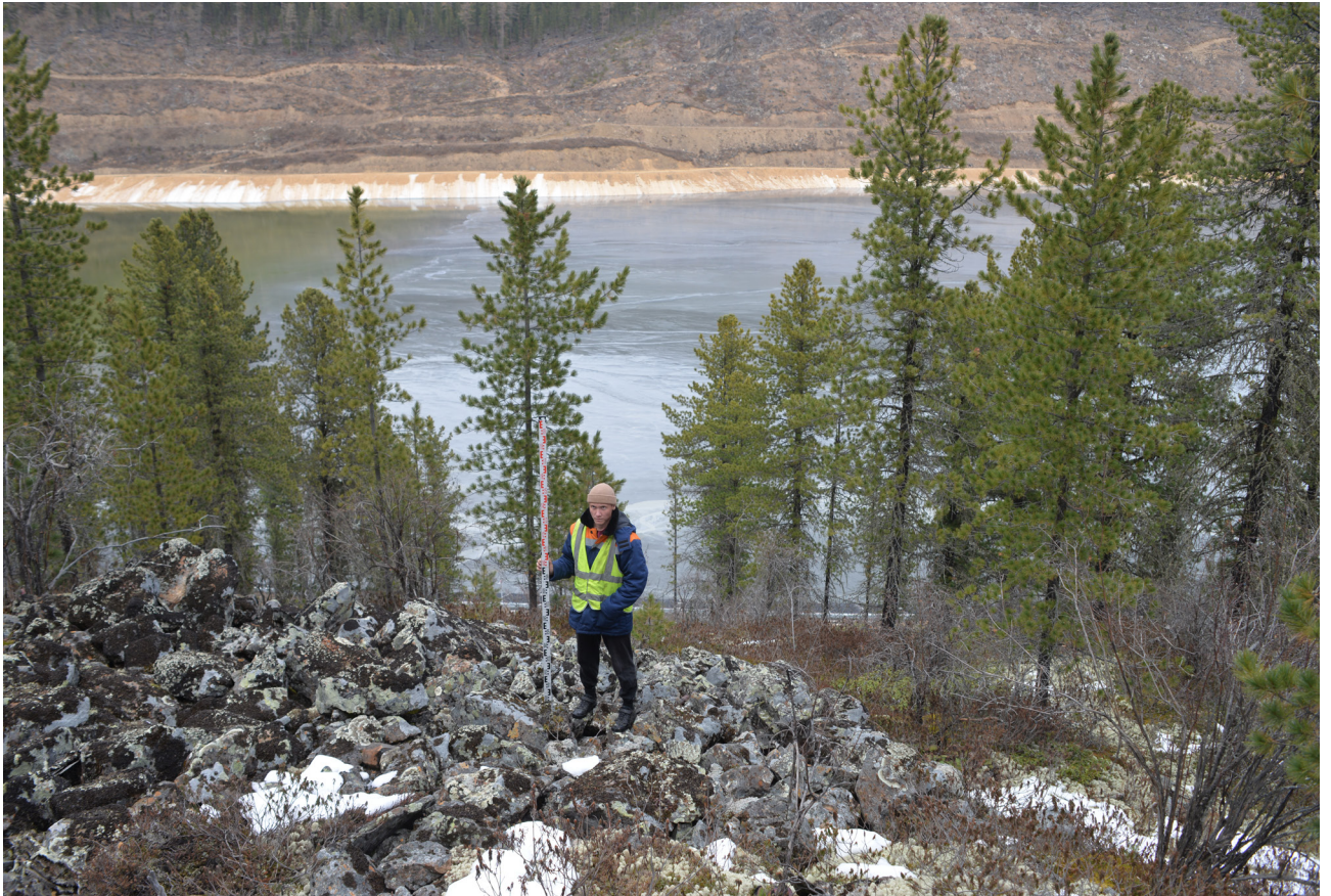
Рис. 59. Увеличение высоты дамбы. Южный участок. Вид на территорию проектирования от точки видовой фотофиксации №3 с ЮЮЗ.
