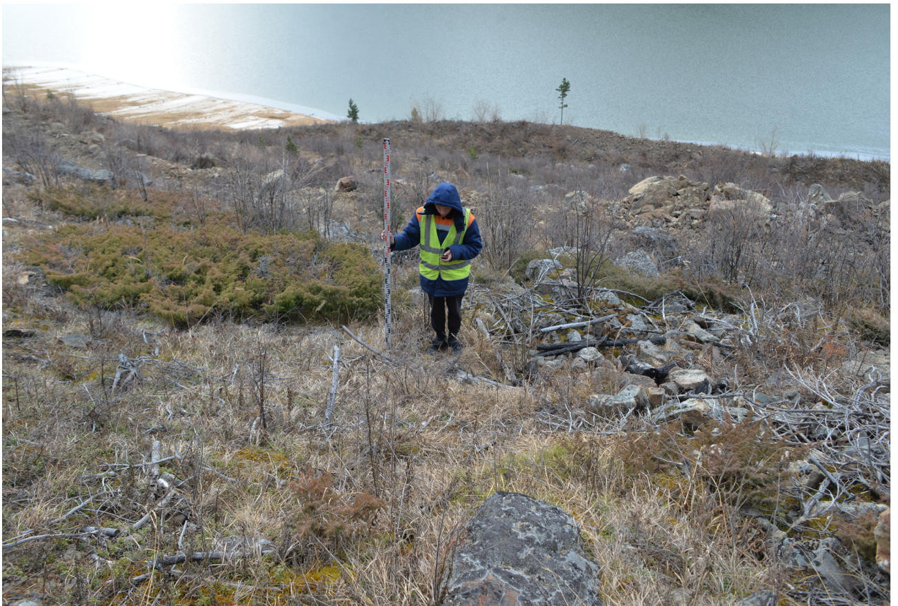
Рис. 22. Увеличение высоты дамбы. Северный участок. Вид на территорию проектирования от точки видовой фотофиксации №5 с севера.
