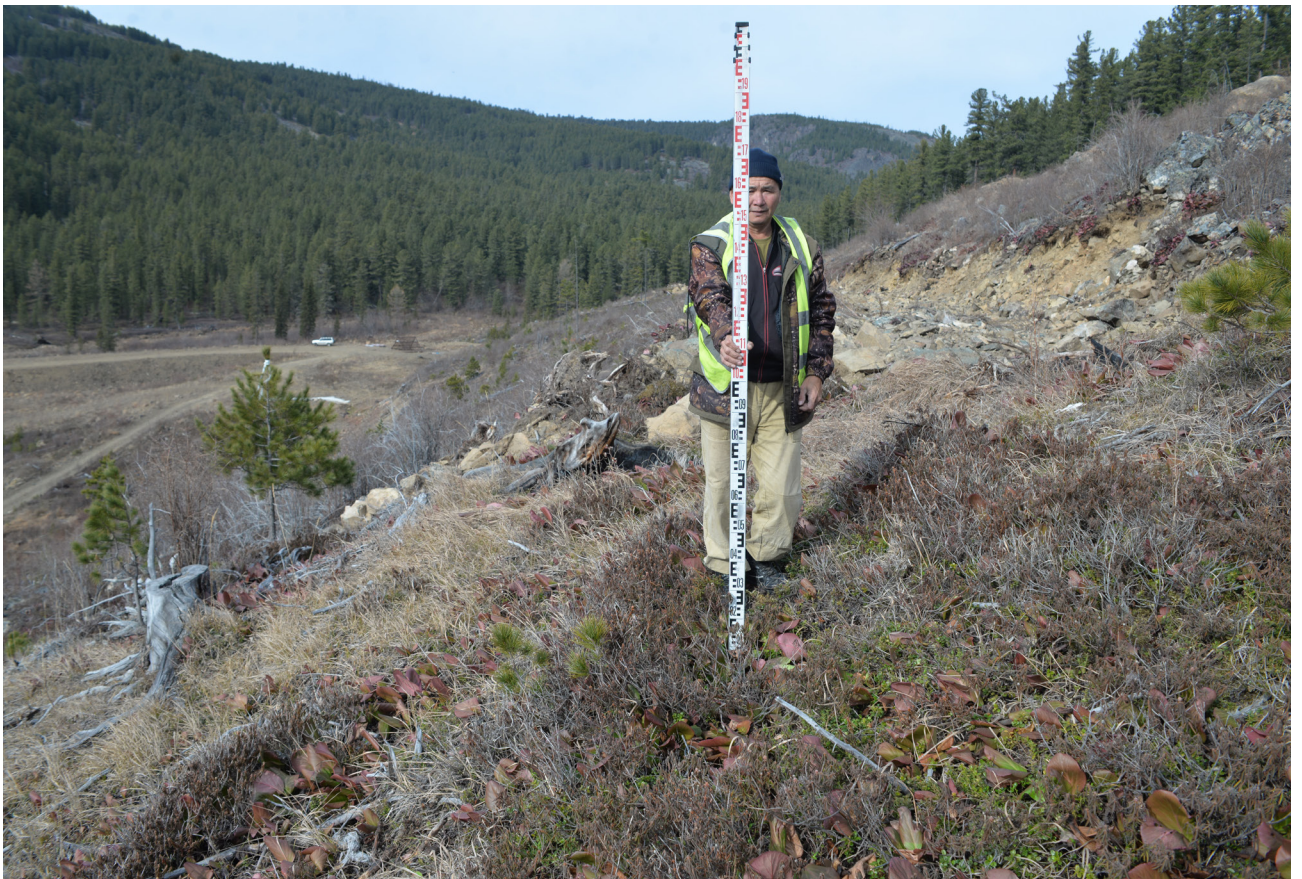
Рис. 42. Увеличение высоты дамбы. Северный участок. Шурф №4. Общий вид с ЮВ до раскопок.
