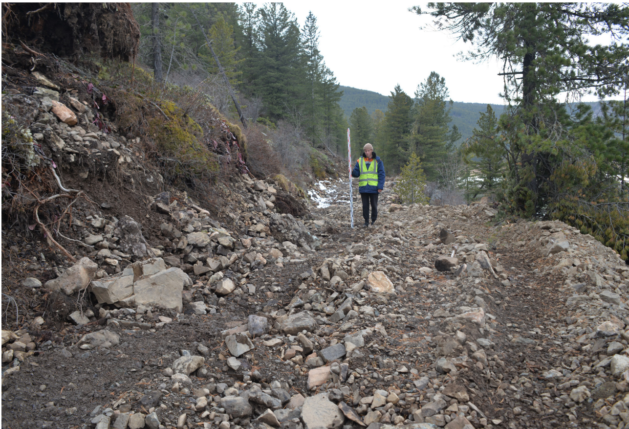
Рис. 63. Увеличение высоты дамбы. Южный участок. Деталь №1. Техногенное разрушение горного склона. Вид с ВЮВ.
