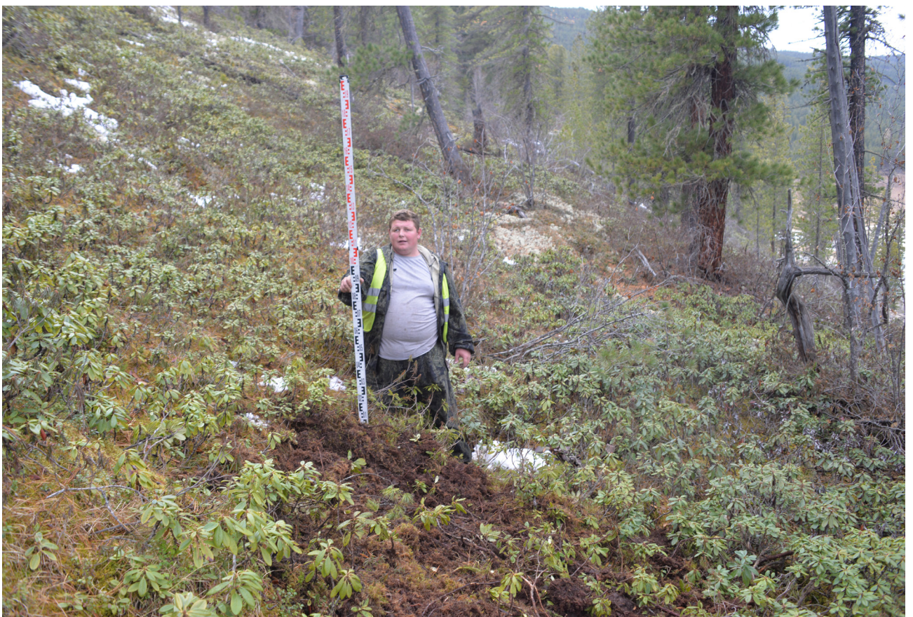
Рис. 71. Увеличение высоты дамбы. Южный участок. Шурф №2. Общий вид с ЮВ после рекультивации.
