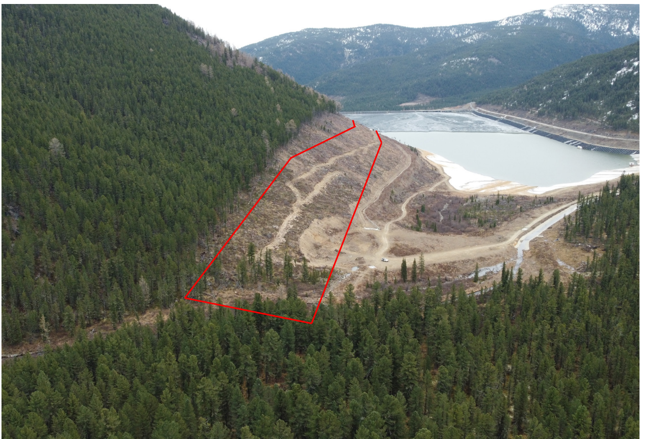
Рис. 13. Увеличение высоты дамбы. Северный участок. Аэрофотосъемка с нанесенным контуром территории проектирования. Вид от точки видовой аэрофотофиксации №3 с ЗСЗ.
