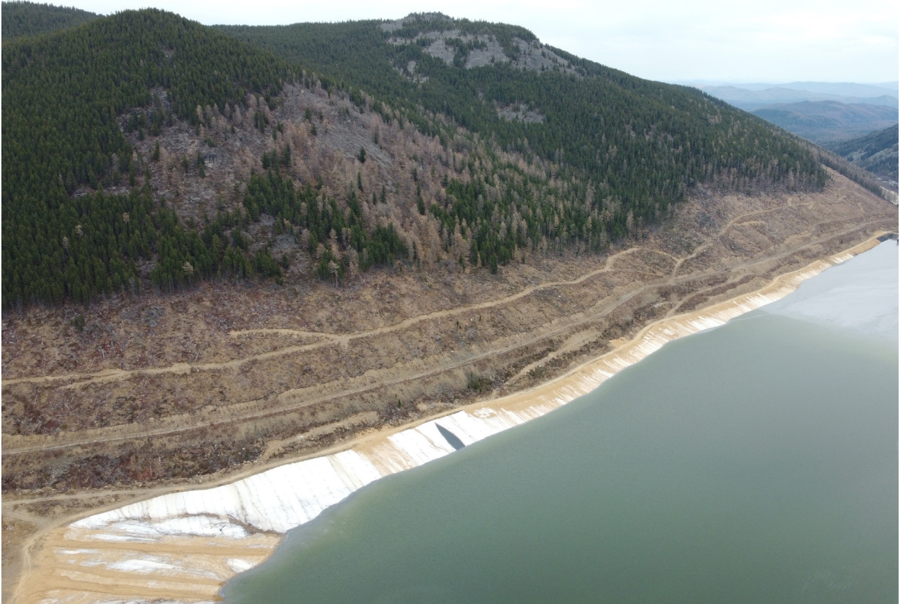
Рис. 8. Увеличение высоты дамбы. Северный участок. Аэрофотосъемка. Вид от точки видовой аэрофотофиксации №1 с ЮЮЗ.
