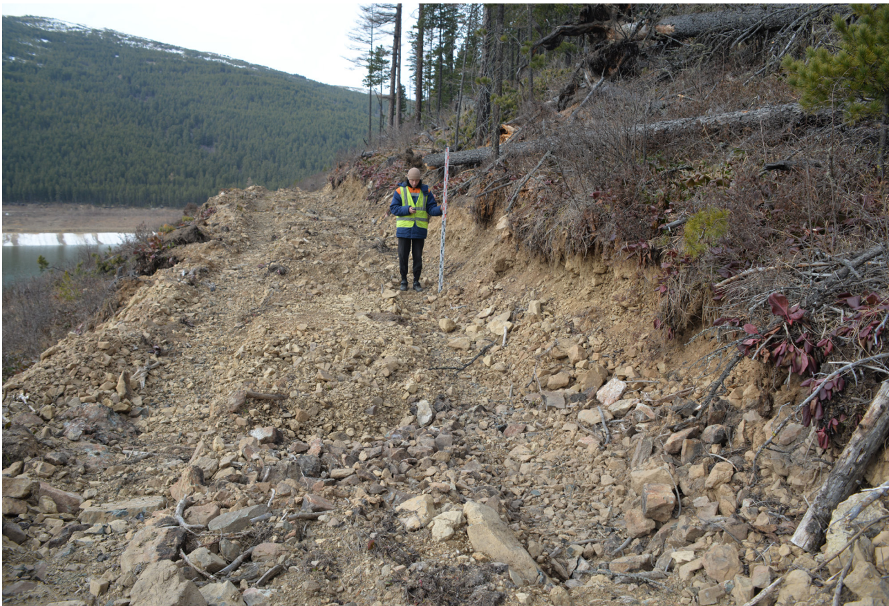
Рис. 26. Увеличение высоты дамбы. Северный участок. Вид на территорию проектирования от точки видовой фотофиксации №7 с востока.
