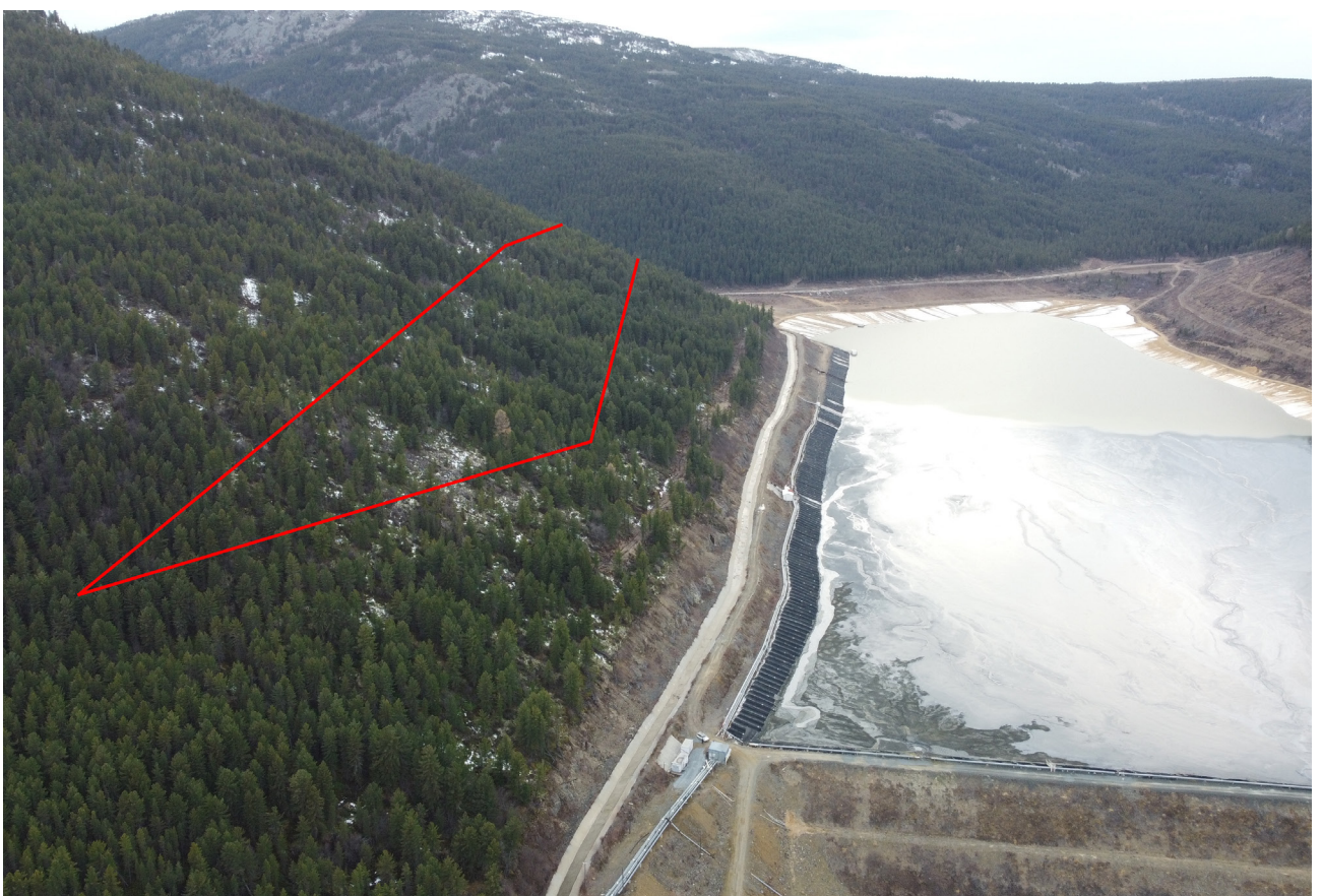
Рис. 54. Увеличение высоты дамбы. Южный участок. Аэрофотосъемка с нанесенным контуром территории проектирования. Вид от точки видовой аэрофотофиксации №2 с ВЮВ.
