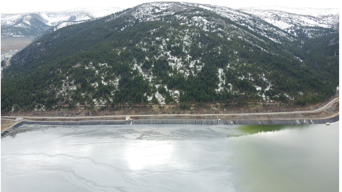
Рис. 55. Увеличение высоты дамбы. Южный участок. Аэрофотосъемка. Общий вид от точки видовой аэрофотофиксации №3 с ССВ.
