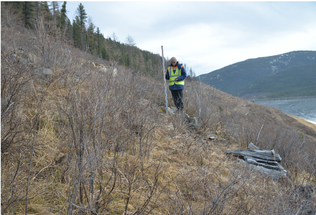
Рис. 24. Увеличение высоты дамбы. Северный участок. Вид на территорию проектирования от точки видовой фотофиксации №6 с ЗЮЗ.
