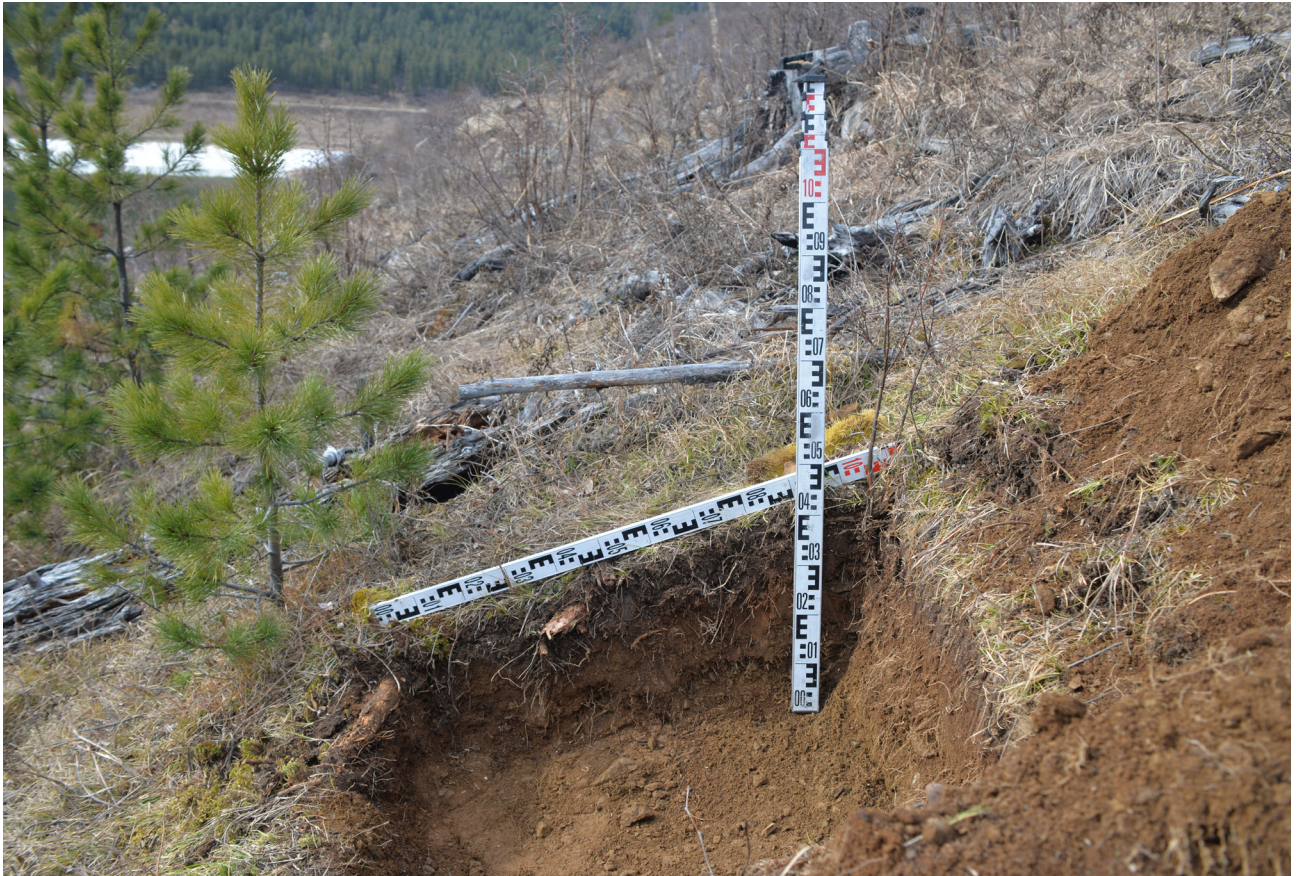
Рис. 48. Увеличение высоты дамбы. Северный участок. Шурф №5. Западная стенка. Вид с востока.
