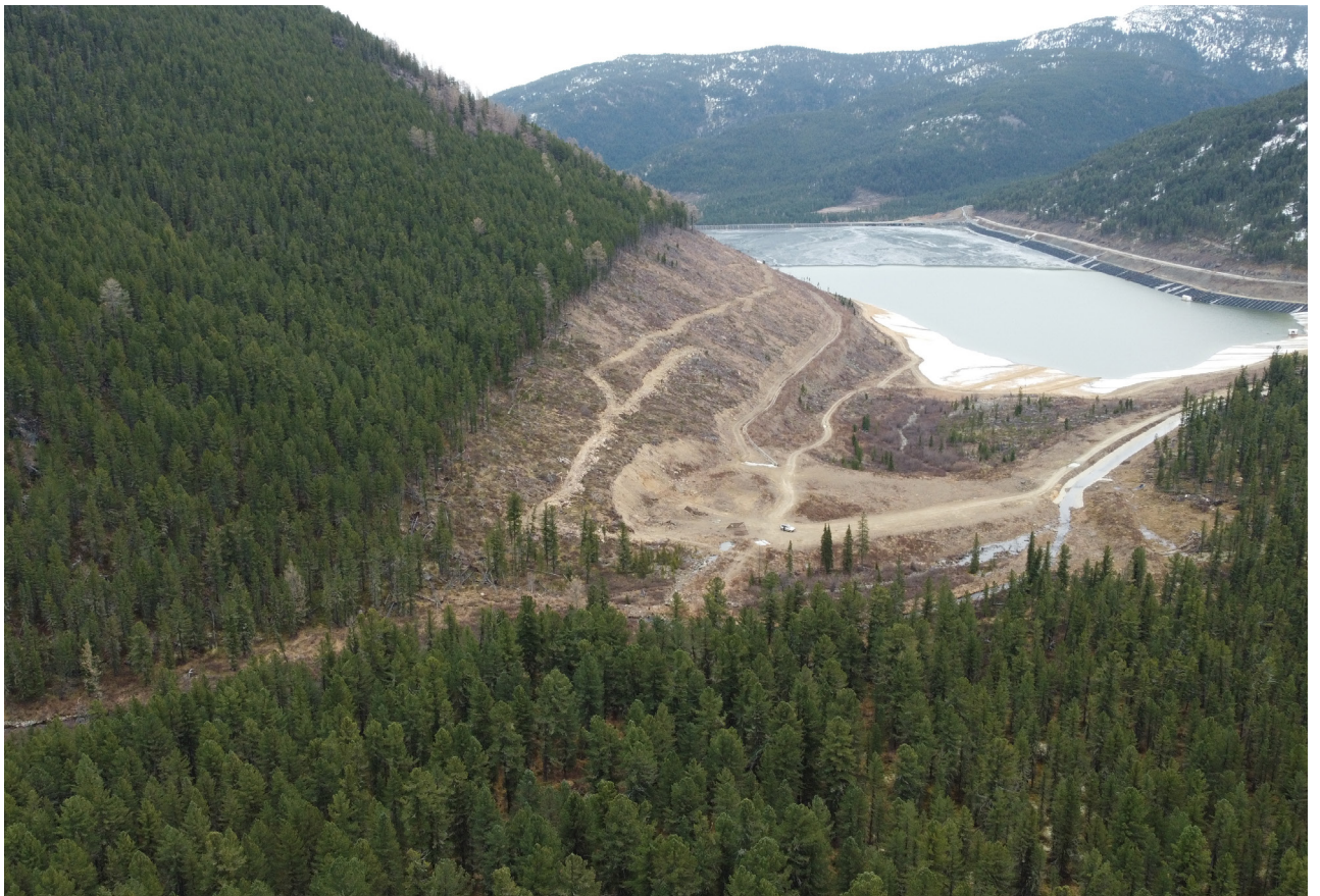
Рис. 12. Увеличение высоты дамбы. Северный участок. Аэрофотосъемка. Вид от точки видовой аэрофотофиксации №3 с ЗСЗ.
