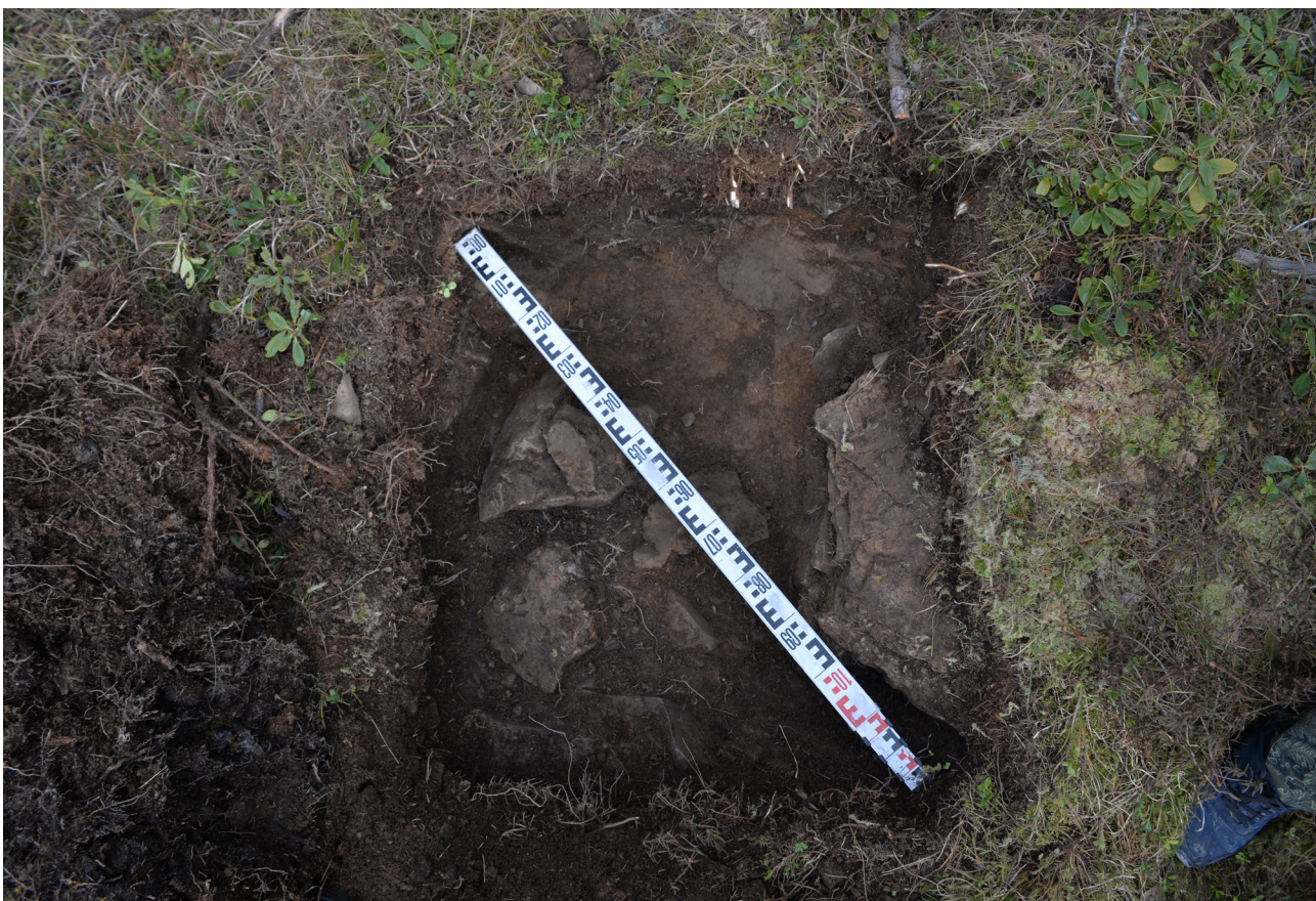
Рис. 31. Увеличение высоты дамбы. Северный участок. Шурф №1. Общий вид с ЮВ.
