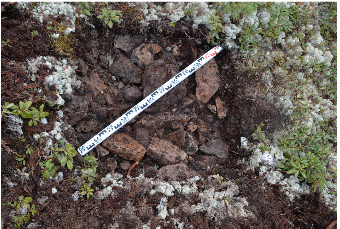
Рис. 65. Увеличение высоты дамбы. Южный участок. Шурф №1. Общий вид с СВ.
