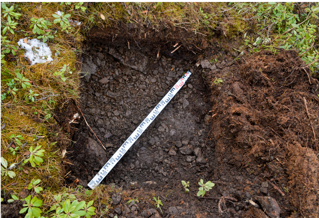
Рис. 69. Увеличение высоты дамбы. Южный участок. Шурф №2. Общий вид с ЮВ.
