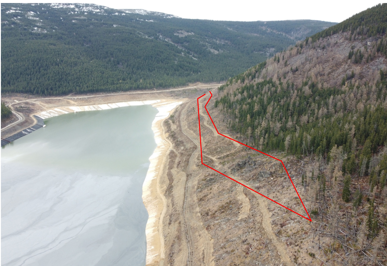
Рис. 11. Увеличение высоты дамбы. Северный участок. Аэрофотосъемка с нанесенным контуром территории проектирования. Вид от точки видовой аэрофотофиксации №2 с ВЮВ.
