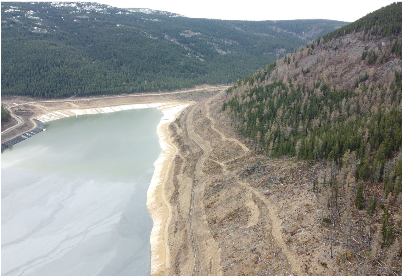
Рис. 10. Увеличение высоты дамбы. Северный участок. Аэрофотосъемка. Вид от точки видовой аэрофотофиксации №2 с ВЮВ.
