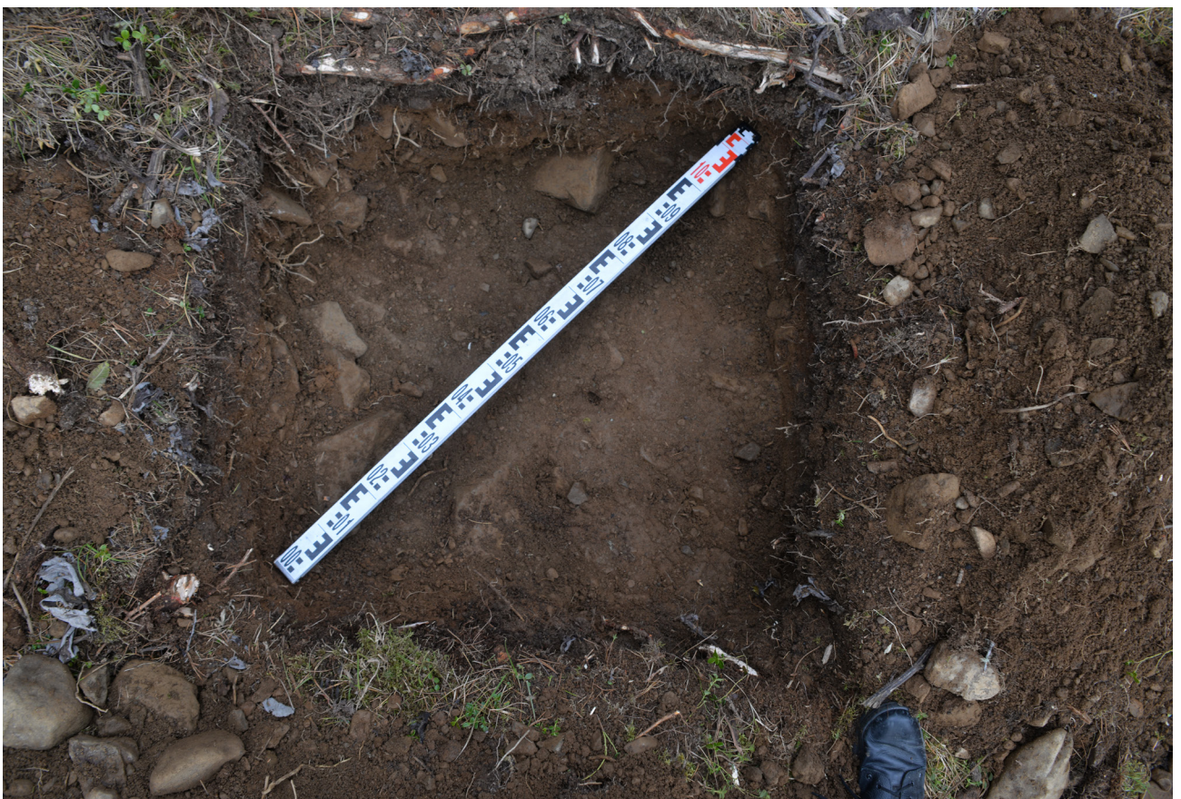
Рис. 35. Увеличение высоты дамбы. Северный участок. Шурф №2. Общий вид с юга.
