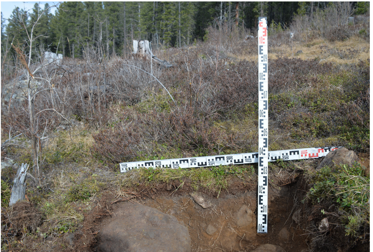
Рис. 40. Увеличение высоты дамбы. Северный участок. Шурф №3. СЗ стенка. Вид с ЮВ.
