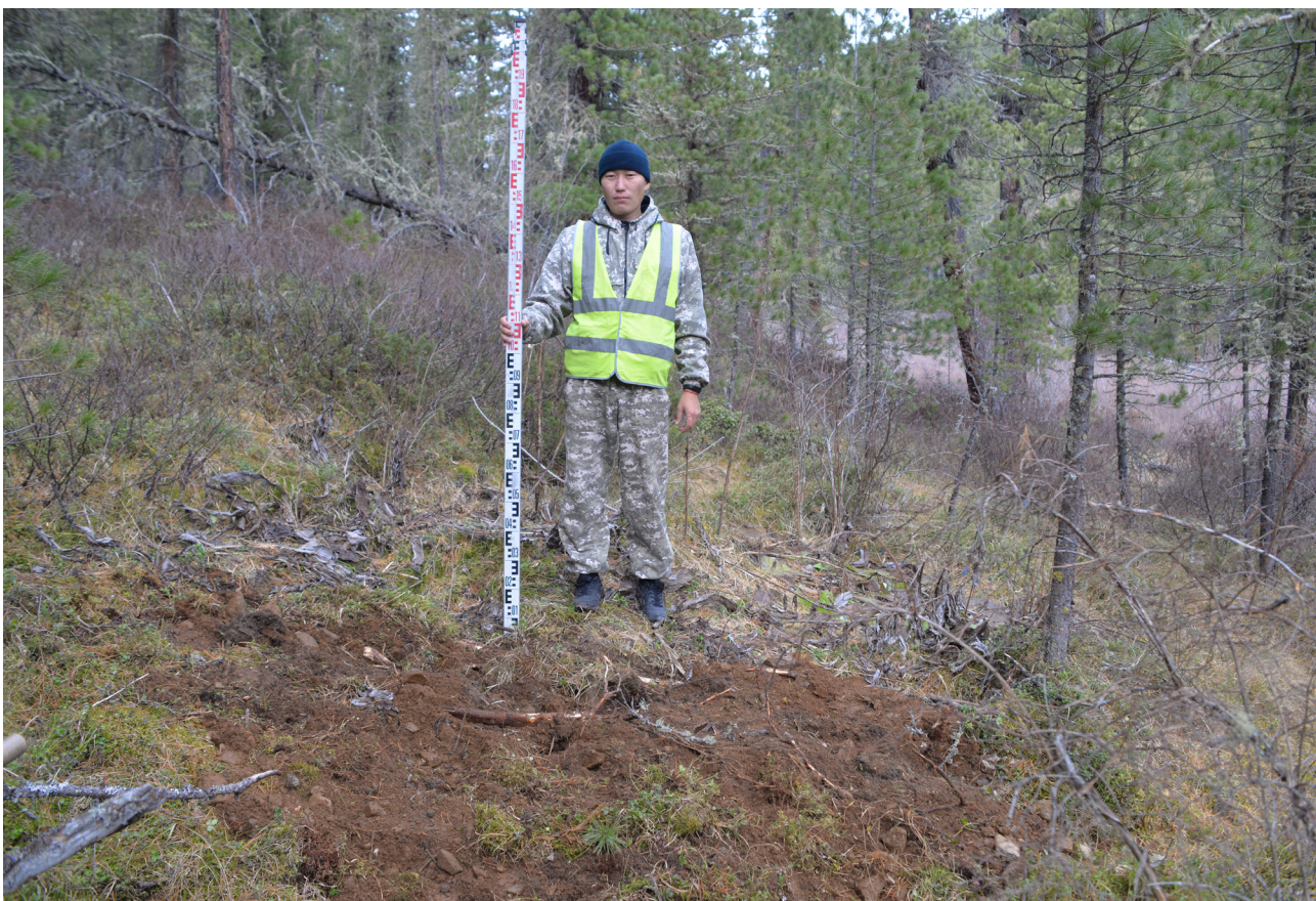
Рис. 37. Увеличение высоты дамбы. Северный участок. Шурф №2. Общий вид с юга после рекультивации.
